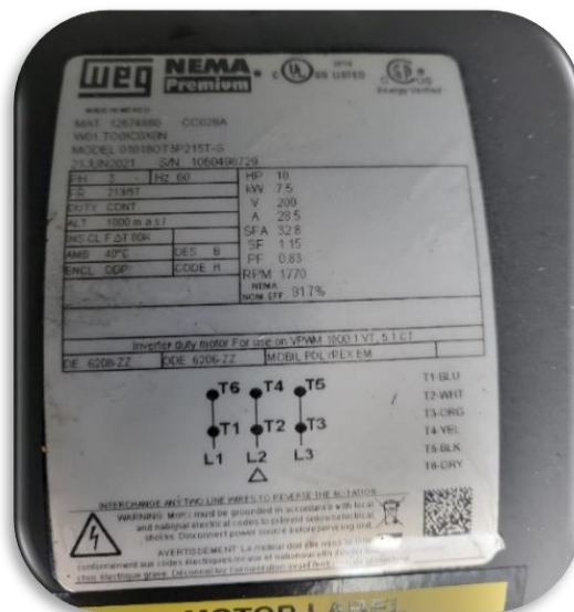
Supply Fan Nameplate
