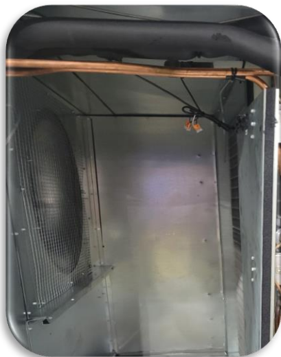
Supply Fan Mesh
